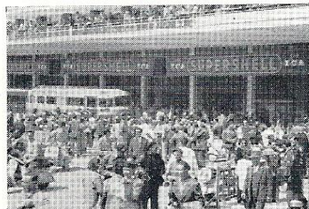
Indgangen til den kæmpestore underjordiske garage, hvor de tusinder af Vespa'er blev anbragt under San Remo-opholdet.
